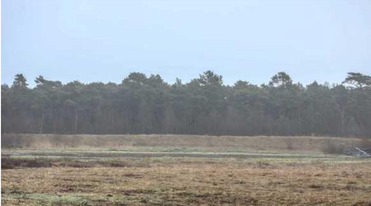
Auf das Sicherungsbauwerk, die sogenannte Wurst, sollen die Sanierungsplaner ein besonderes Auge haben. Der Erdwall wurde 2006/2007 mit belastetem Bodenaushub gebaut und abgedichtet.
